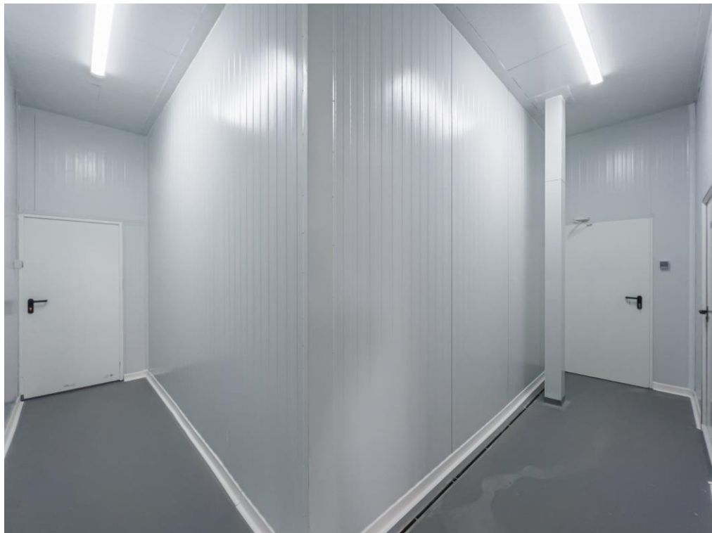
Ilustración 7 Pasillo planta baja
