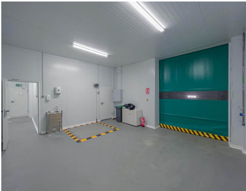
Ilustración 11 Zona de acondicionamiento. Pasillo a la izquierda
